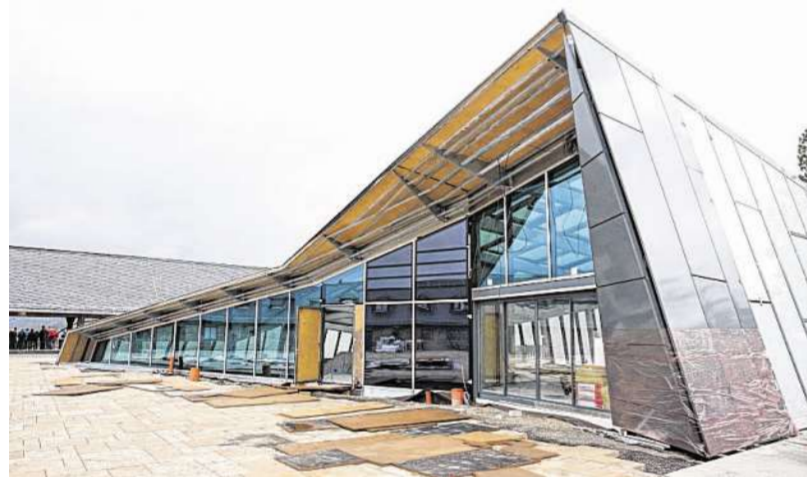
Baustelle: Im futuristischen neuen Besucherzentrum soll die Geschichte von Vogelsang ebenso präsentiert werden wie die Gegenwart.
